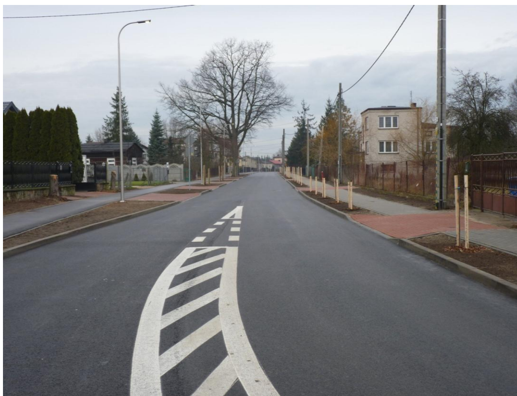
Ulica Spacerowa oddana do użytku po rozbudowie (grudzień 2019 r.).
