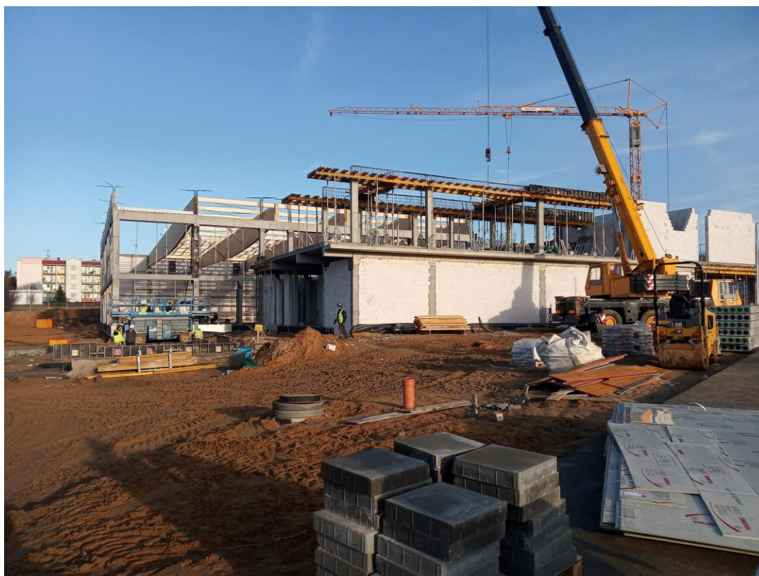
Budowa kompleksu basenowego w Radomsku, ul. Królowej Jadwigi, stan na 20.12.2019r.
