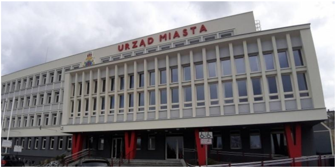
Budynek Urzędu Miasta Radomska po termomodernizacji. Inwestycja dofinansowana w ramach Regionalnego Programu Operacyjnego Województwa Łódzkiego na lata 2014-2020 (październik 2019 r.).
